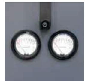
**Differenzdruckverlust über den Filtern**
