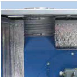
Flex-Verbindung - nur für reine Luft. An Einlauf und Abluft montiert.
