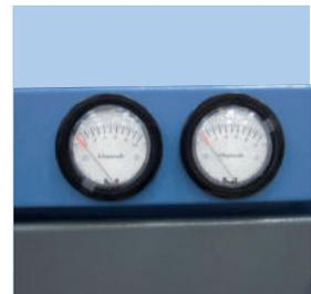
**Differenzdruckverlust über die Filtern**
